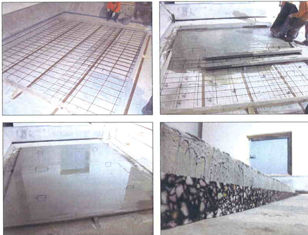
Imágenes 3, 4, 5 y 6 Detalles de la construcción de la losa y colocación de los paneles Copopren®
