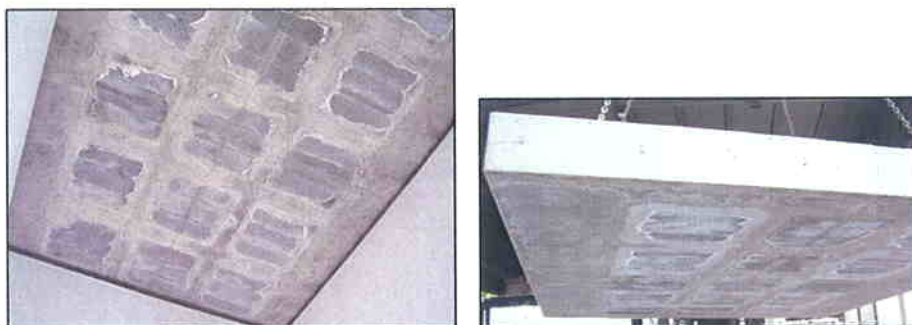
Imágenes 3 y 4 Forjado de hormigón armado
