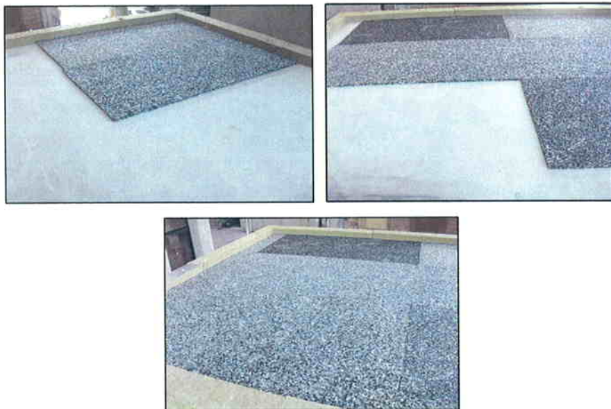
Imágenes 5, 6 y 7 Colocación del panel Copopren sobre el forjado
