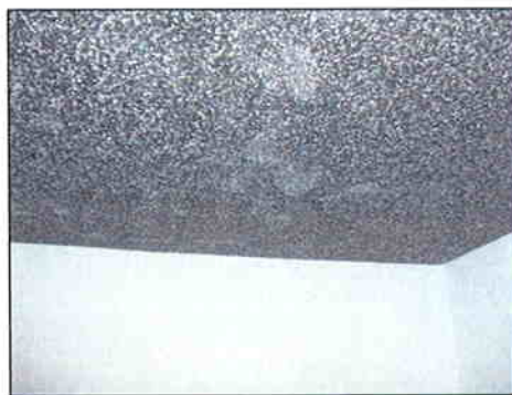
Imagen 5 Panel Copopren encolado al forjado
