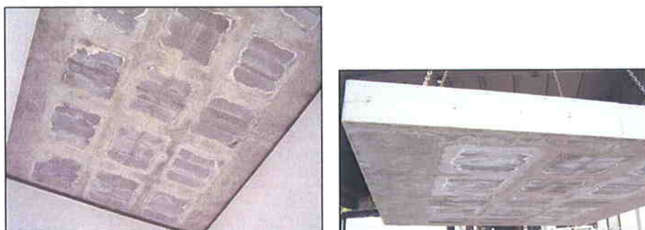
Imágenes 3 y 4 Forjado de hormigón armado
