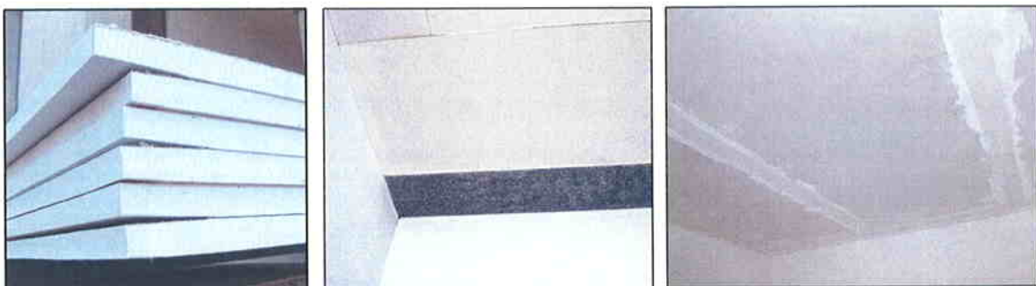
Imágenes 6, 7 y 8 Placas de yeso laminado y su encolado sobre el panel
