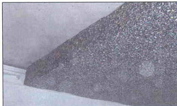
Imagen 5 Panel Copopren encolado al forjado
