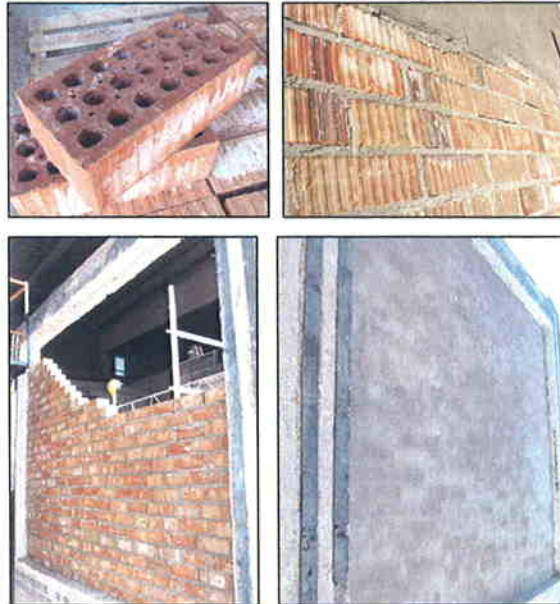
Imágenes 3, 4, 5 y 6 Detalles del panel
