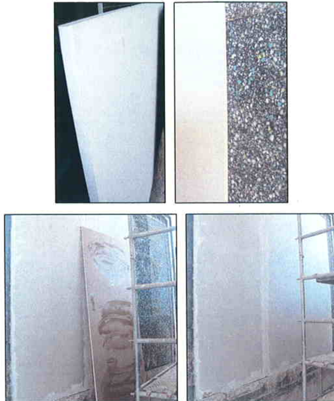
Imágenes 9, 10, 11 y 12 Placa de yeso laminado y su encolado sobre el panel
